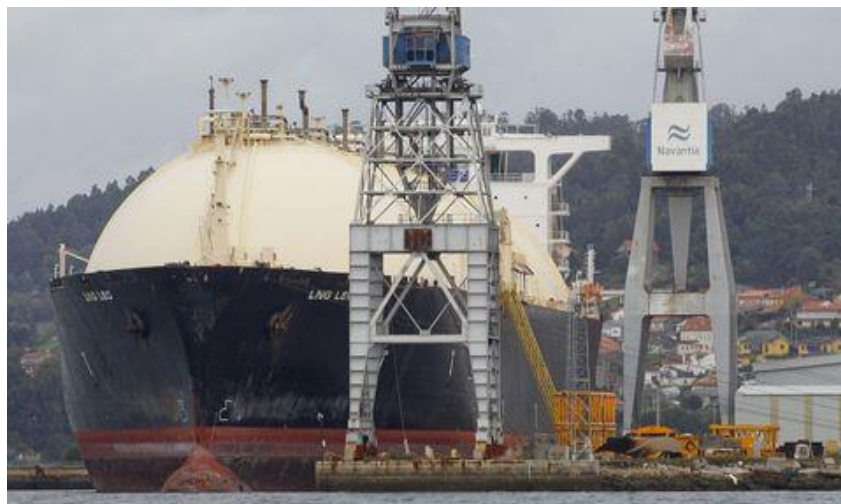
Fig.2. Imagen reparación de buque a flote (fuente: https://cadenaser.com/emisora/2017/03/29/radio_menorca/1490791010_667001.html )
