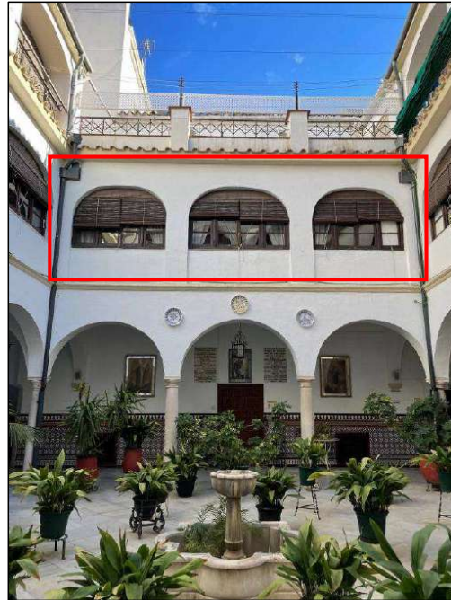
Carpinterías de la Galería Este de Planta Primera
