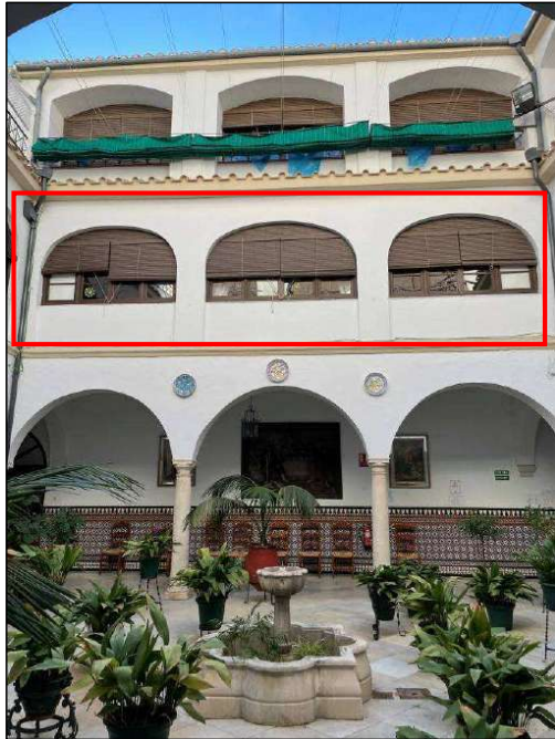
Carpinterías de la Galería Sur de Planta Primera
