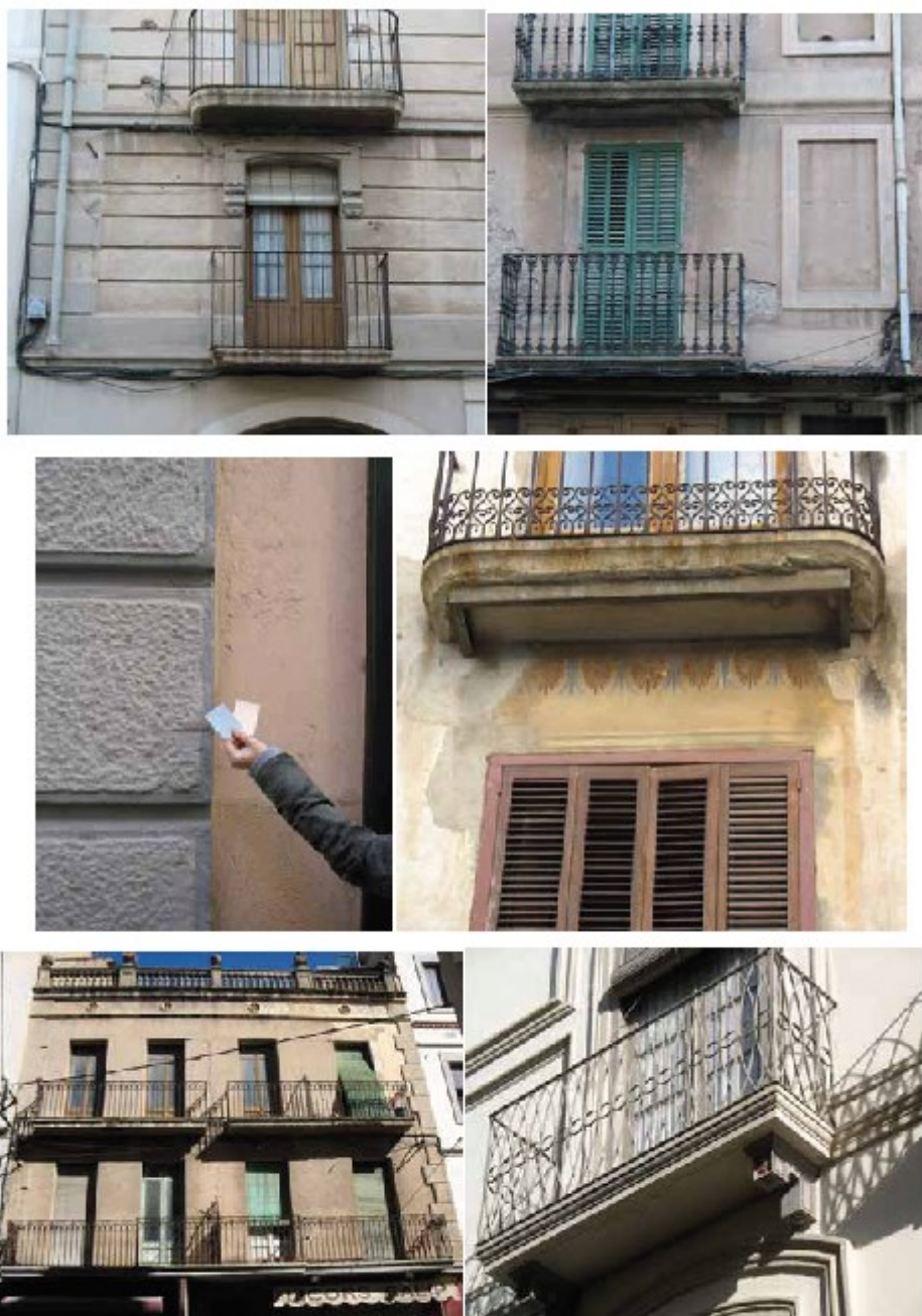
Elements de l'arquitectura eclèctica.
