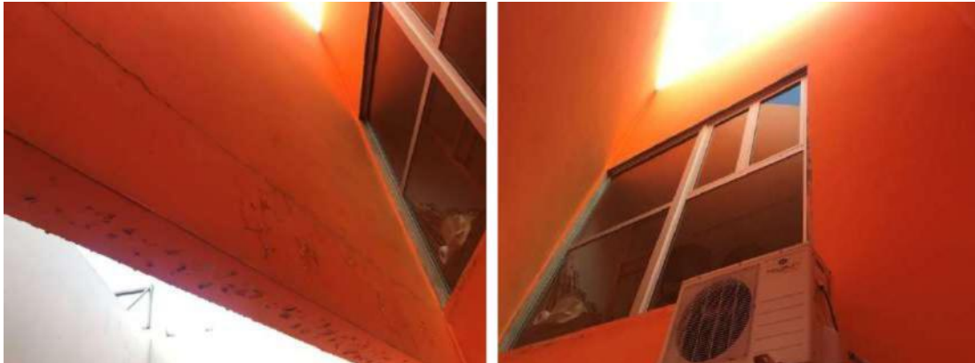
Estado de los paramentos del patio situado junto a locales de ensayo. 22 diciembre 2021
