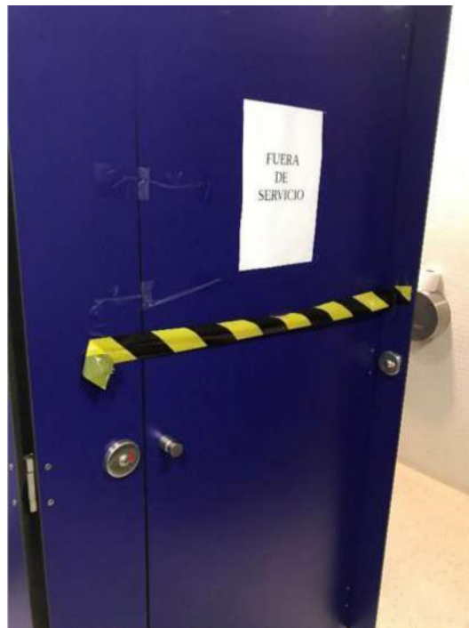
Inodoro fuera de servicio. Casa de Juventud de El Rosario. EL Chorrillo. 1 de abril de 2022.
