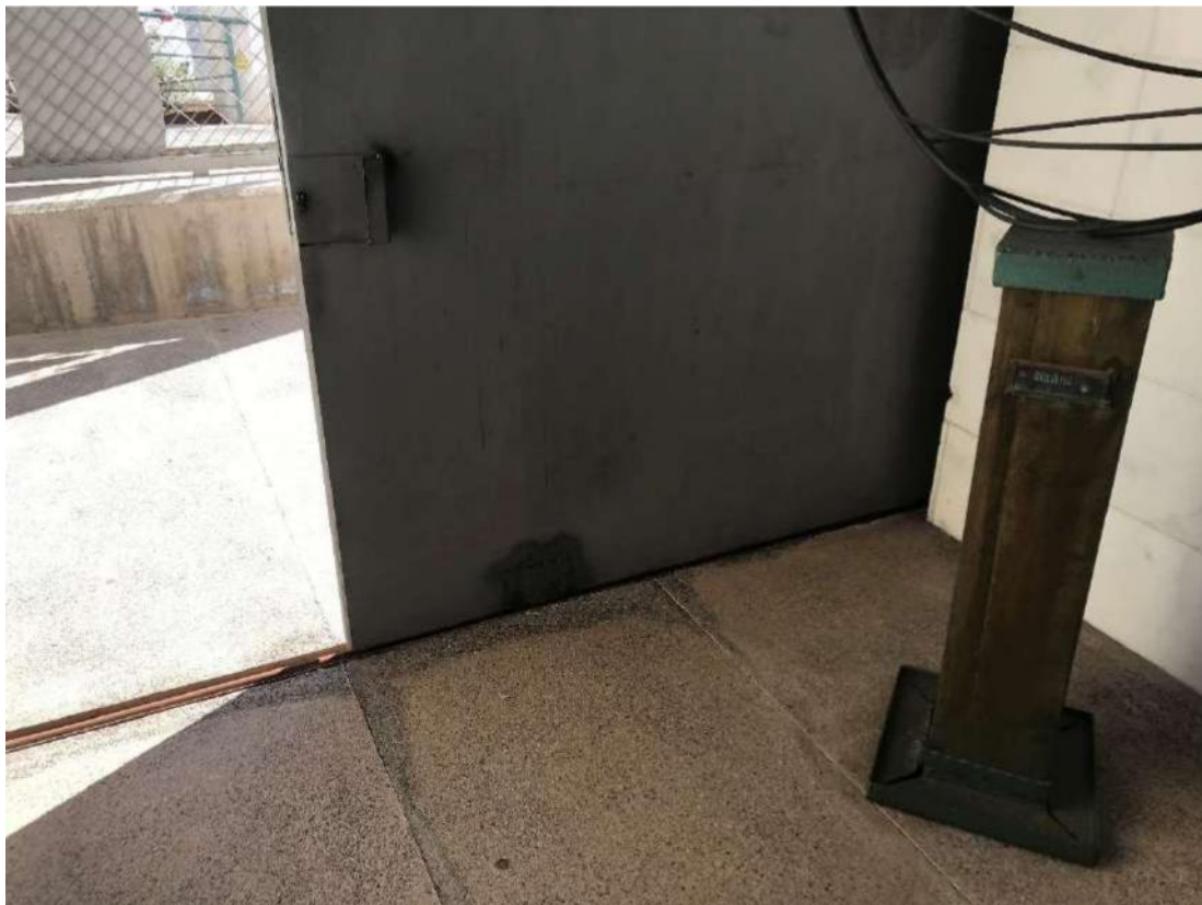
Puerta metálica en acceso principal. Casa de Juventud de El Rosario. EL Chorrillo. 1 de abril de 2022
