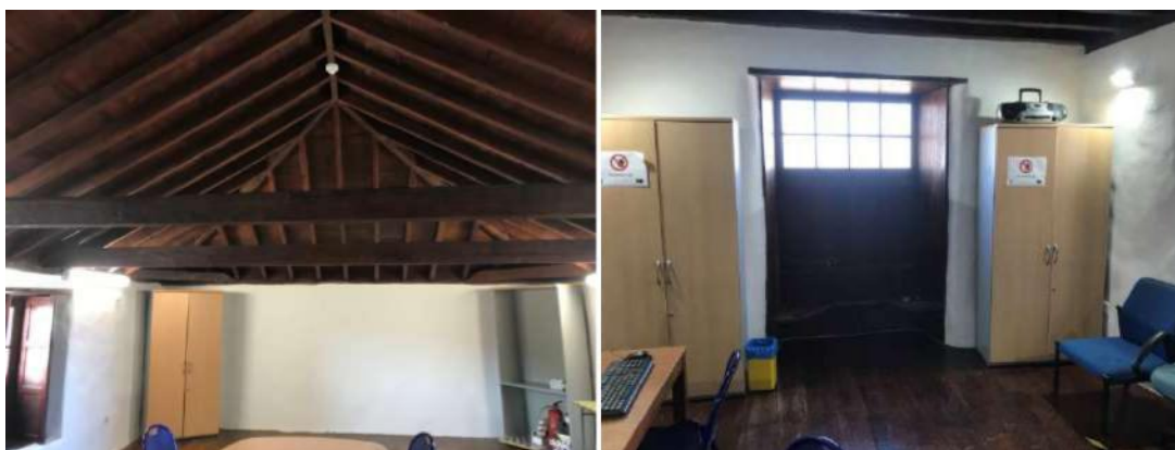
Estado actual de los paramentos interiores. 14 de diciembre 2021
