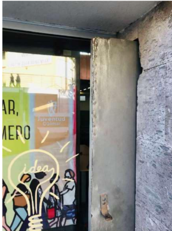
Puerta metálica en acceso principal. Casa de Juventud de Güímar. 1 de abril de 2022.
