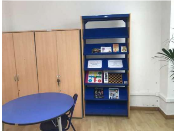
Sala 3 humedad detrás de la estantería. 16 de febrero de 2022.
