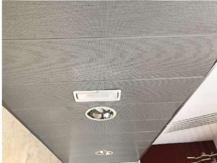
Falso techo metálico en planta Alta Casa de Juventud de Casa de Juventud de Güímar. 1 de abril de 2022
