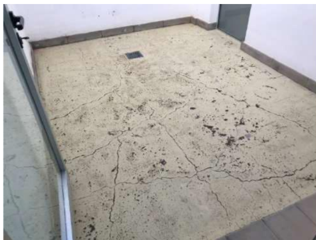
Estado actual de patio sobre almacén. 14 diciembre 2021.
