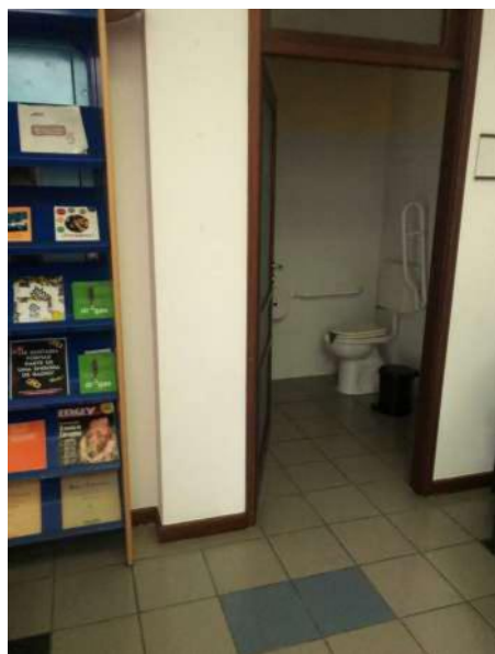
Estado actual de baño de planta baja para personas con movilidad reducida. 14 de diciembre de 2021.
