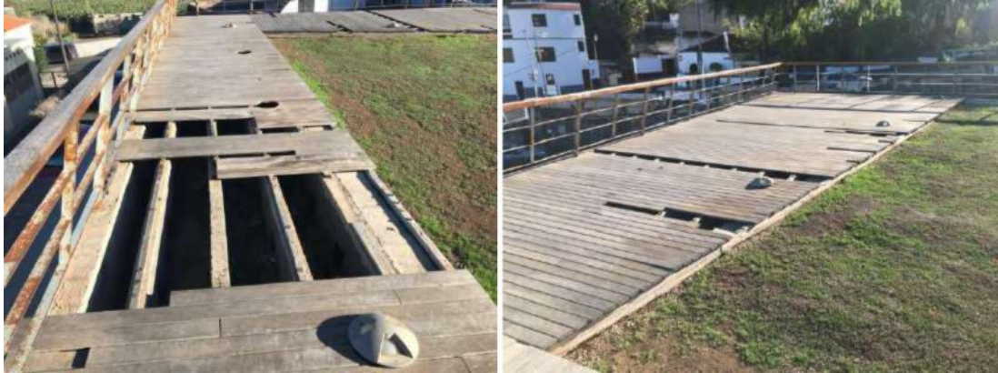
Estado actual de tarima, barandilla y luminarias de la cubierta de la Casa de Juventud de Los Silos 22 12 2021
