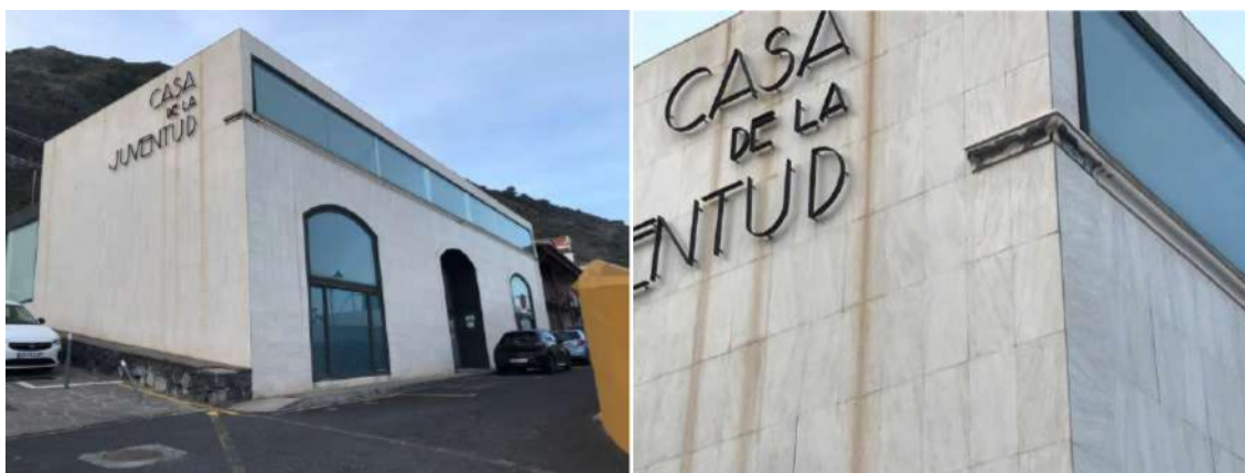
Estado actual de la fachada de la Casa de Juventud de Garachico. 14 de diciembre de 2021.
