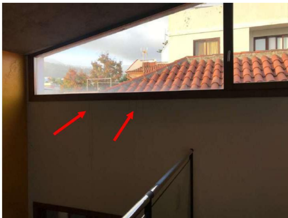
Estado de la carpintería emplazada sobre el Hall principal. 18 de enero de 2022.
