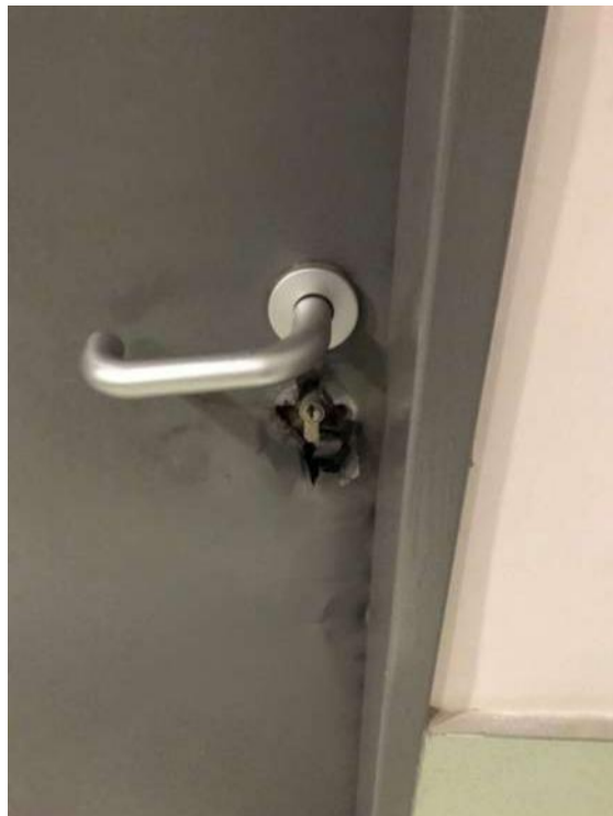
Puerta metálica en acceso a patio. Zona de locales de ensayos.21 de enero de 2022.
