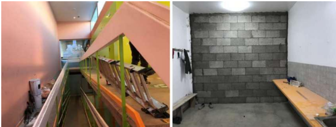
Estado actual de cerramientos laterales de Casa de Juventud
