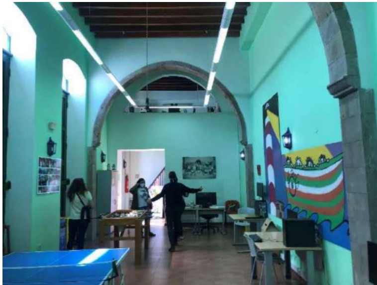
Estado de la Cerrajería en acceso a la casa de Juventud. Necesita ser lijada y pintada. Granadilla de Abona. 7 de marzo de 2022.
