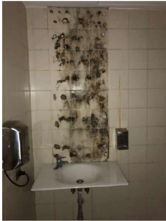
Falta de espejo en baño PMR. 14 diciembre 2021
