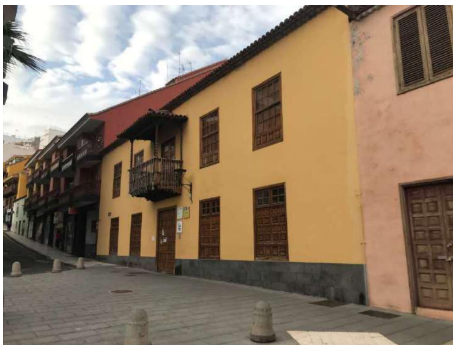
Fachada del edificio de Casa de Juventud de Puerto de La Cruz .21 de enero de 2022.
