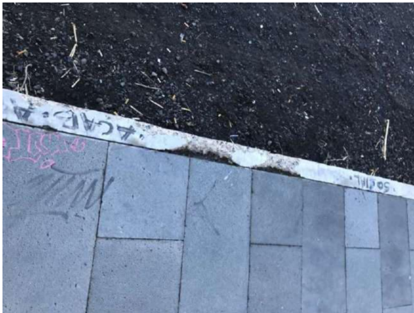
Estado actual de la casa de Juventud de Los Silos. 22 diciembre 2021
