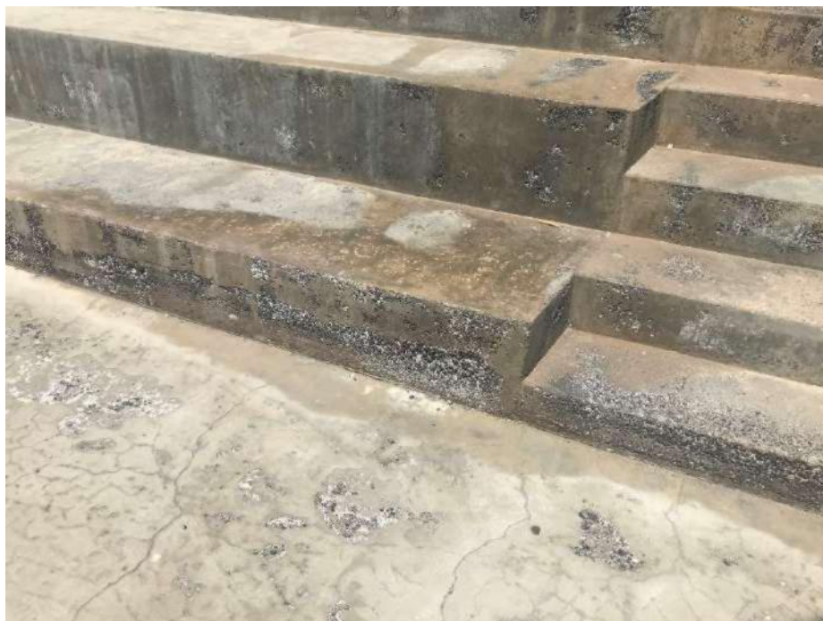
Escalera de acceso a Casa de Juventud de Santiago del Teide. 20 de mayo de 2022
