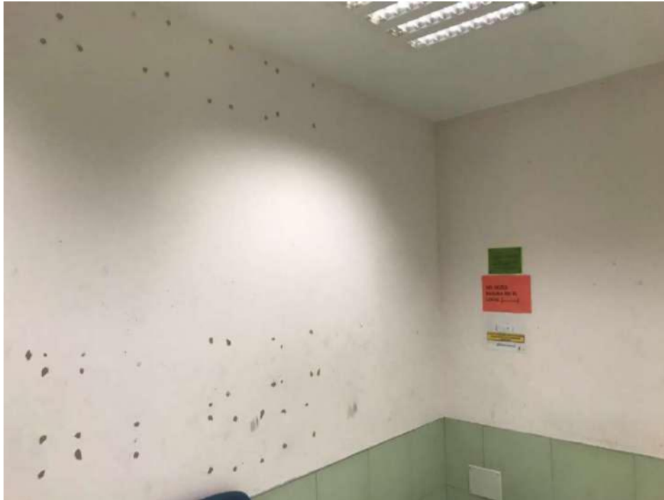
Salas de ensayos. 21 de enero de 2022.
