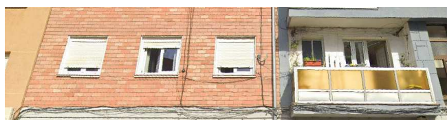
Foto fachada vivienda
