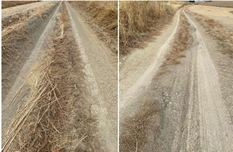
Fotos ilustrativ as de estado actual de Cordel de Granad a. Tramo IV, donde se pretend e actuar.
